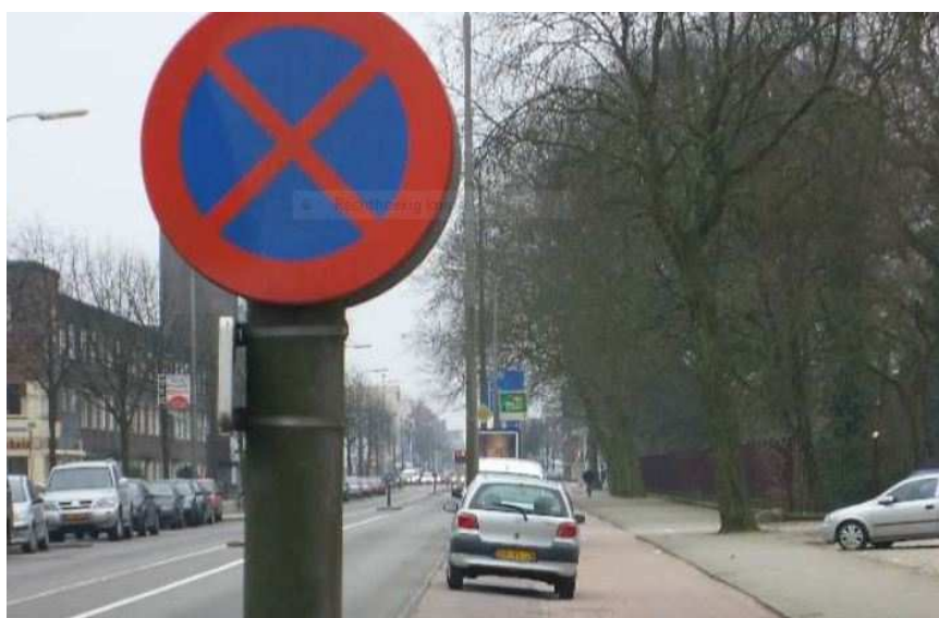
Afbeelding 7: Parkeerverbod op de Amsterdamsestraatweg ter hoogte van het Julianapark. Duidelijk zichtbaar is dat er auto's deels op het fietspad geparkeerd staan.
