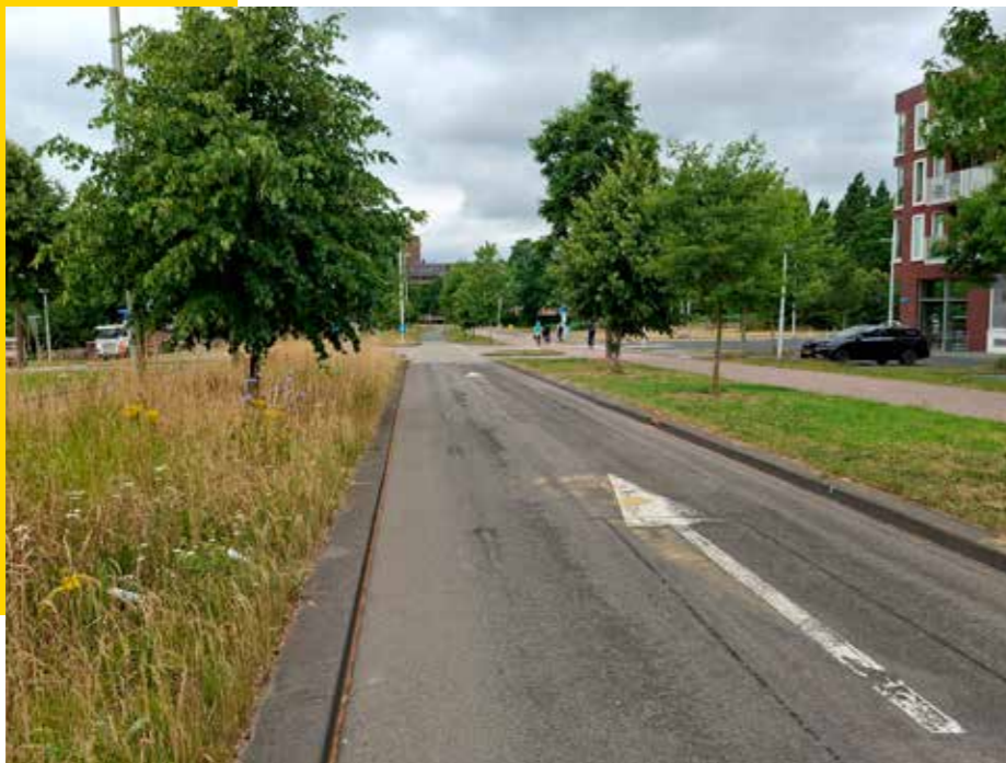
Hogeweidebaan in Leidsche Rijn voor en na het verwijderen van de verkeersregelininstallatie. © Foto's: Fietsersbond
