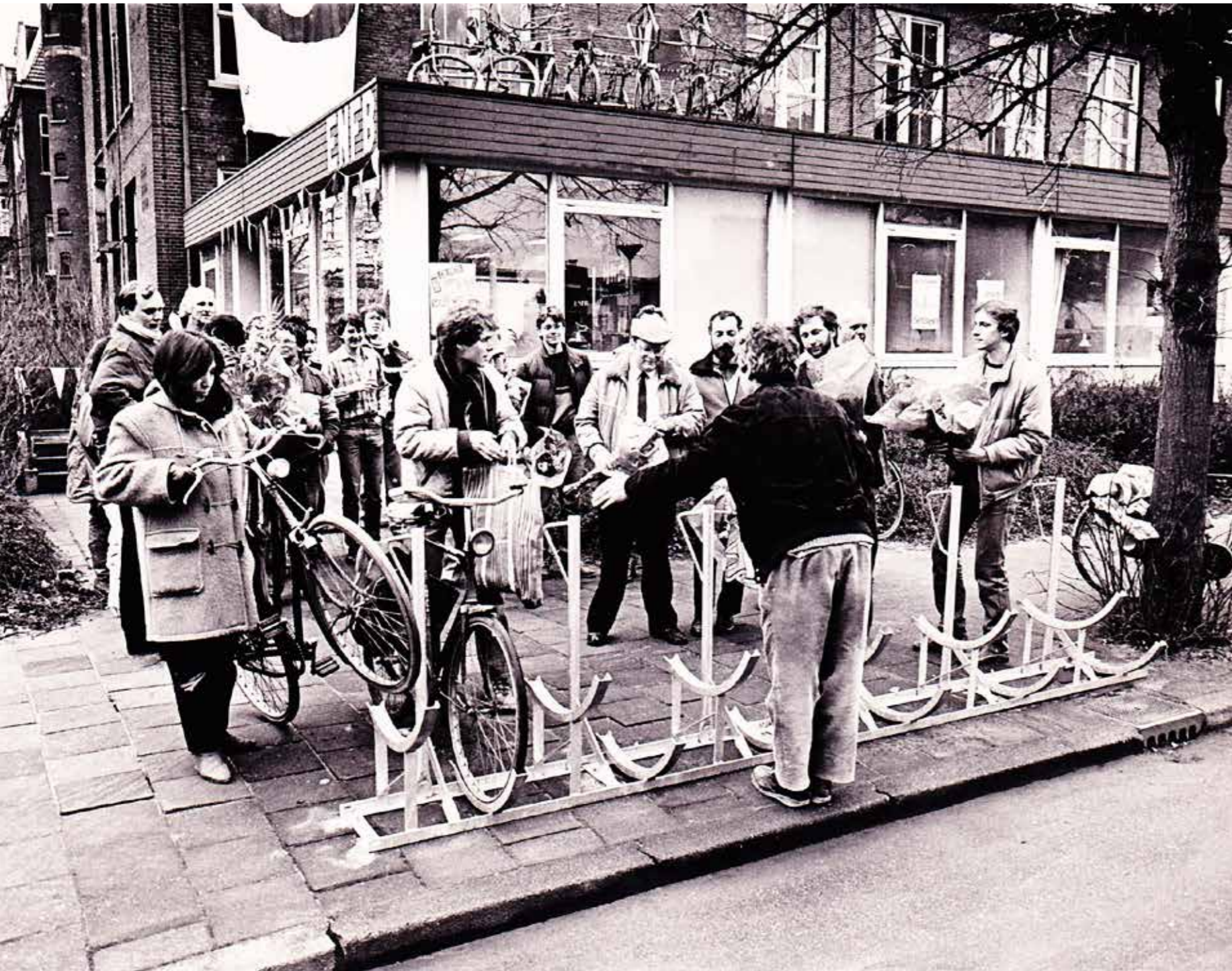
Amsterdamse fietsenrek, in 1985 ontwikkeld in een samenwerking met Fietzersbond Amsterdam, de gemeente en fabrikant. Het was het eerste rek met aanbindmogelijkheid. Binnen een jaar waren er meer dan 1.500 geplaatst in de stad. © Foto: archief Fietzersbond Amsterdam
