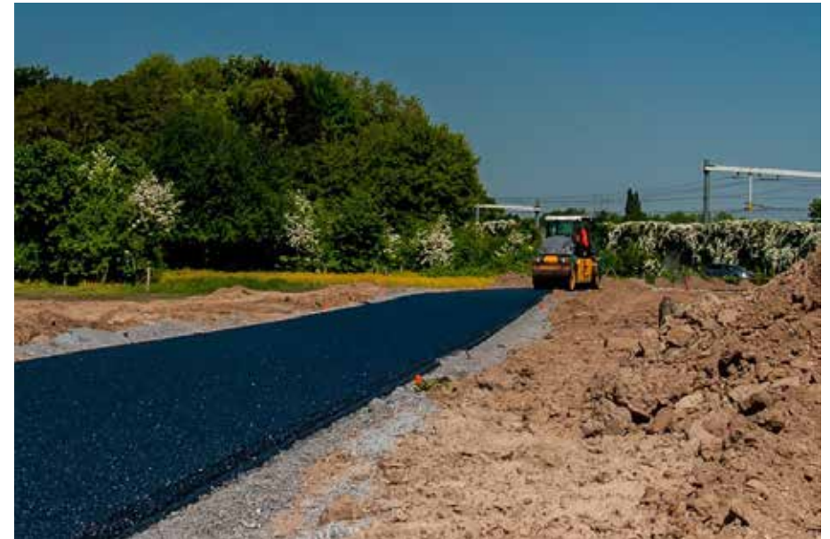
Figuur 4: Circulair Fietspad Zevenaar. Eerste circulaire fietspad gemaakt van grasfalt.
